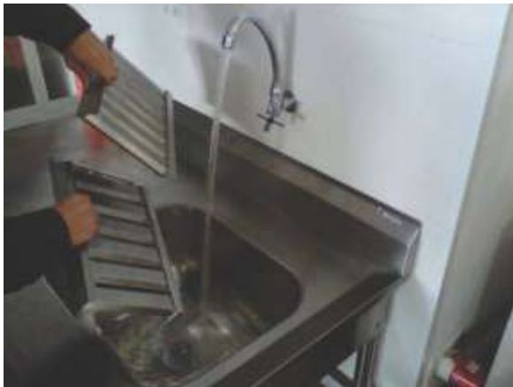
(3º) Este filtro pode ser lavado com água e sabão.
